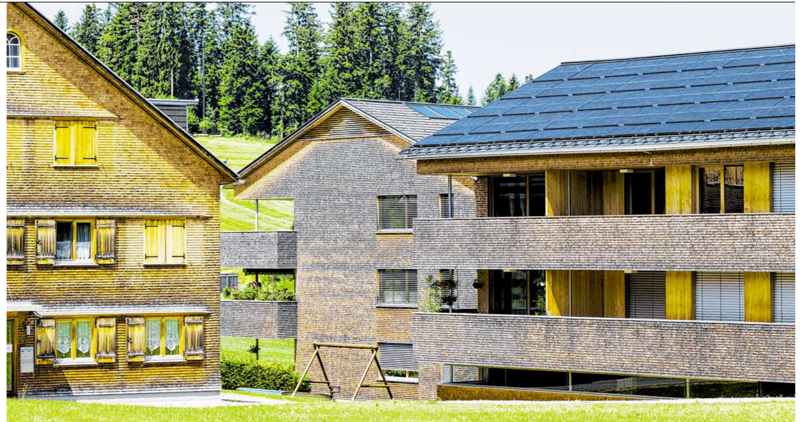
Wahrzeichen. Gemeinnütziger Wohnbau mit hoher Qualität: Die von Hermann Kaufmann geplante Passivhaus-Anlage ist beispielgebend
