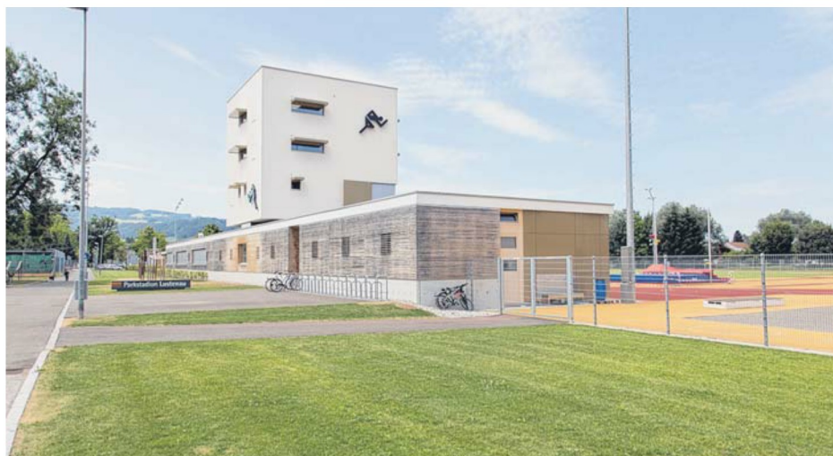
Das neue Parkstadion trug zur deutlichen Verbesserung der Sport-Situation bei.
