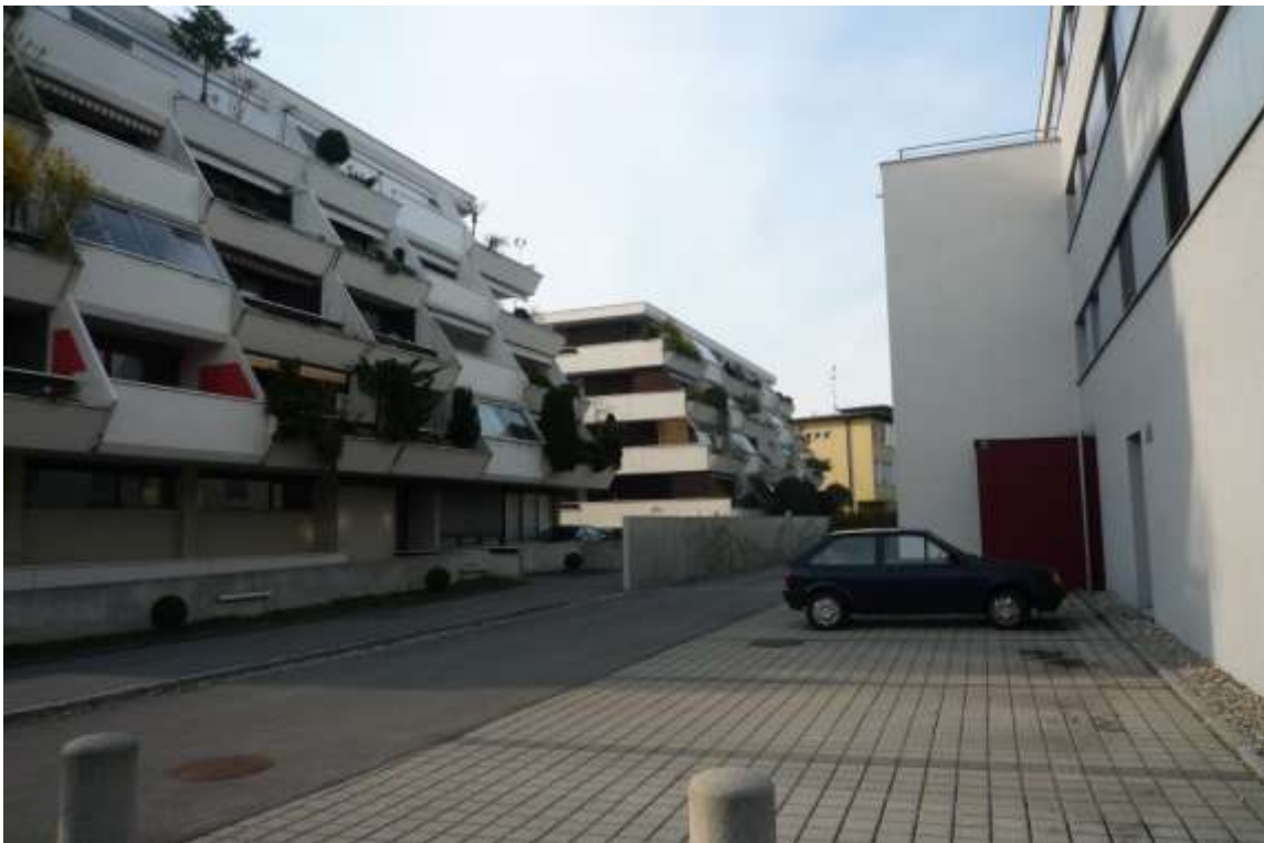
Im Wohnquartier finden sich hohe Baudichten, aber keine geeigneten öffentlichen Freiflächen.
