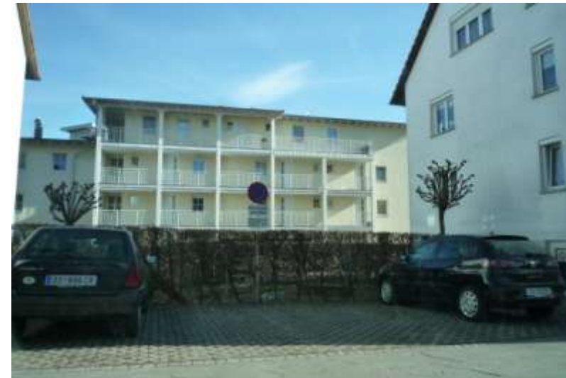
Die nahe VOGEWOSI Wohnanlage an der Bahnhofstraße hat eine hohe Wohndichte, besitzt aber keine Spielmöglichkeiten, die den heutigen Standards entsprechen.
