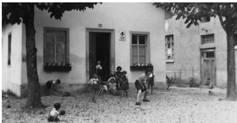
Der Kindergarten Kirchdorf (später Drogerie Jochum) während der NS-Zeit. Rechts die Jahn-Turnhalle.
