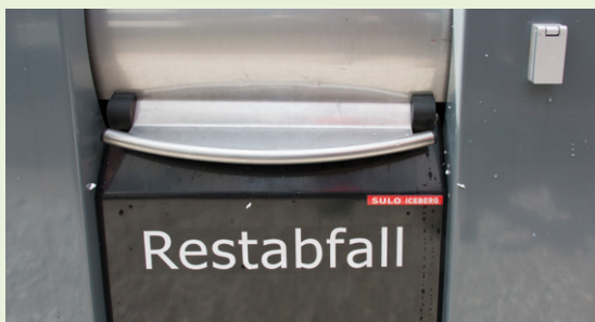
Trommeleinwurf – Zugang mit Schlüssel
