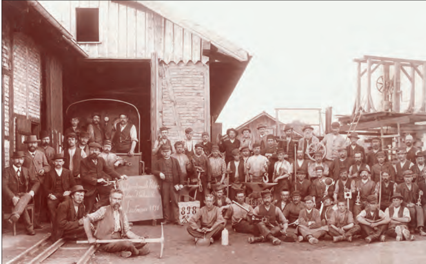
Bauarbeiter der Internationalen Rheinregulierung im Jahr 1898 im Werkhof Lustenau. (Privatbesitz)
