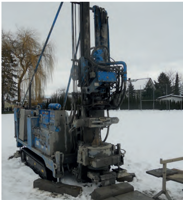
Probebohrungen und Bodensondierung im Frühjahr
