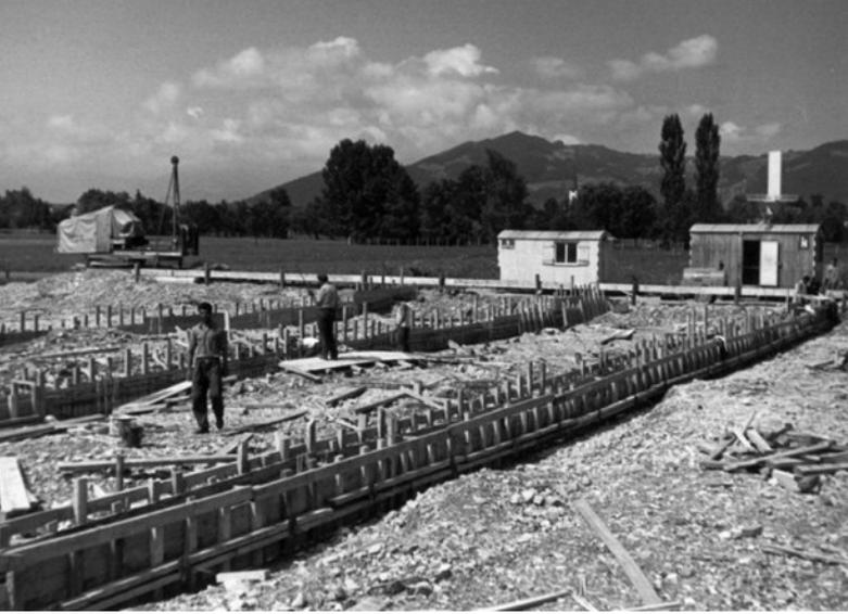
Schalungsarbeiten für die Fundamente der Eishalle.
