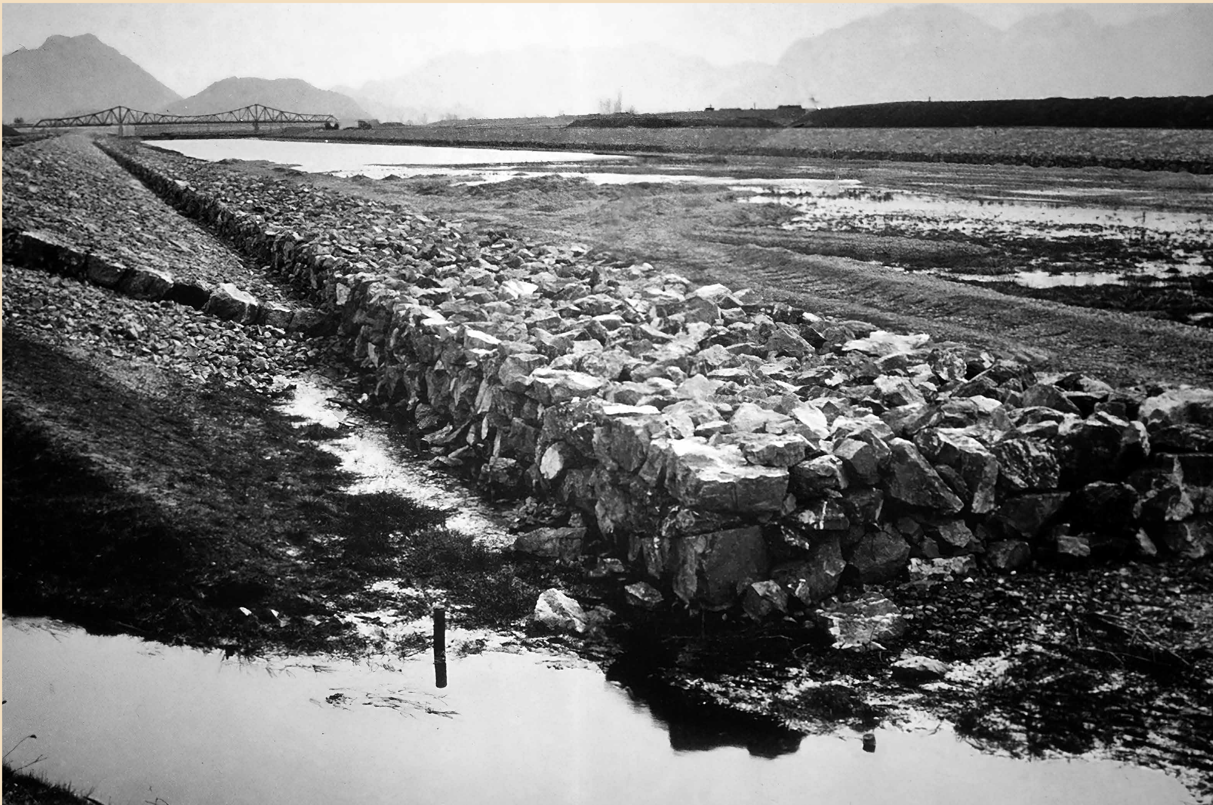
Vorgrund und Böschungspflasterung unterhalb der Trambrücke 1913, Quelle: Internationale Rheinregulierung
