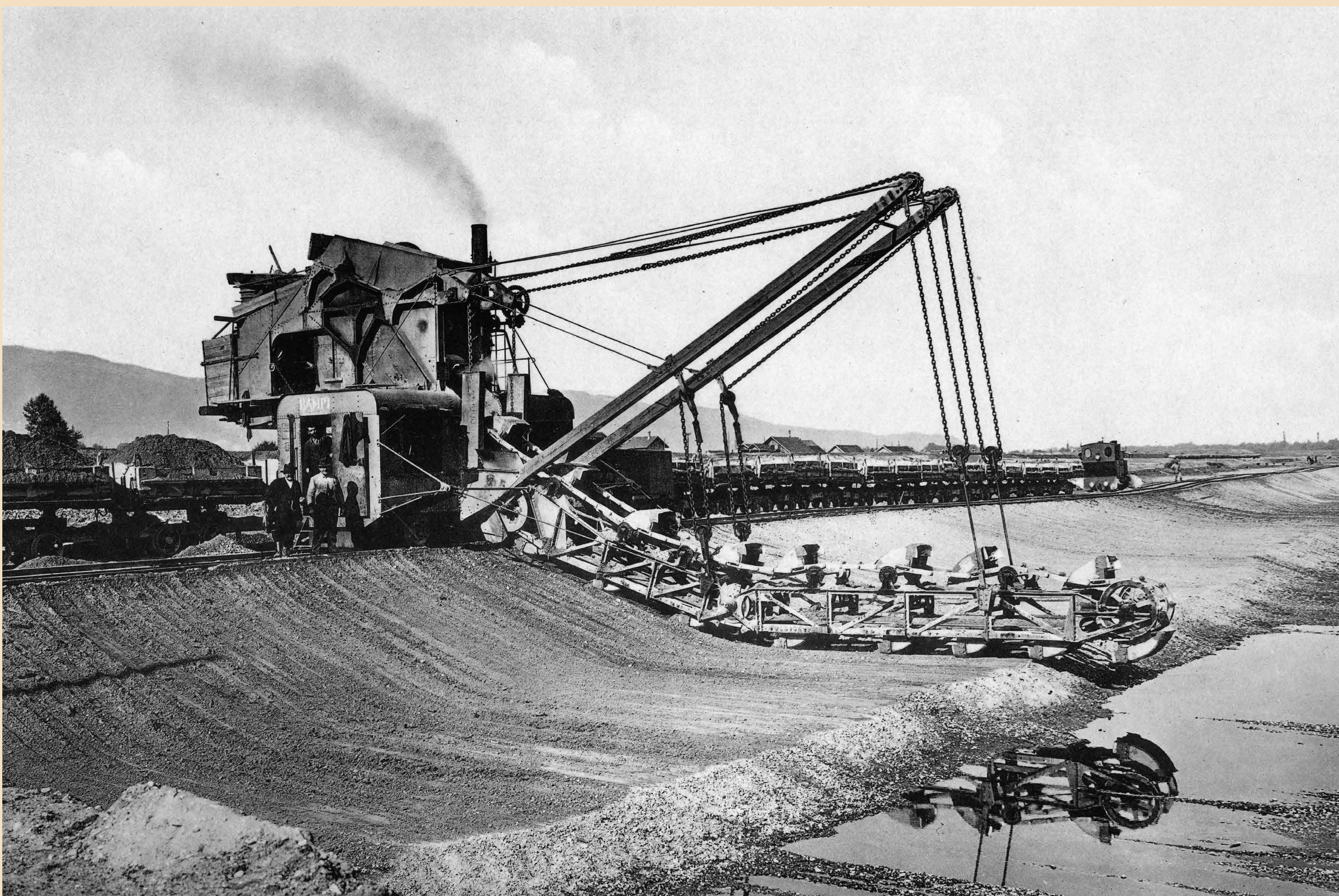
Eimerkettenbagger beim Aushub des Mittelgerinnes und Beladen der Kastenkipper 1911, Quelle: Internationale Rheinregulierung
