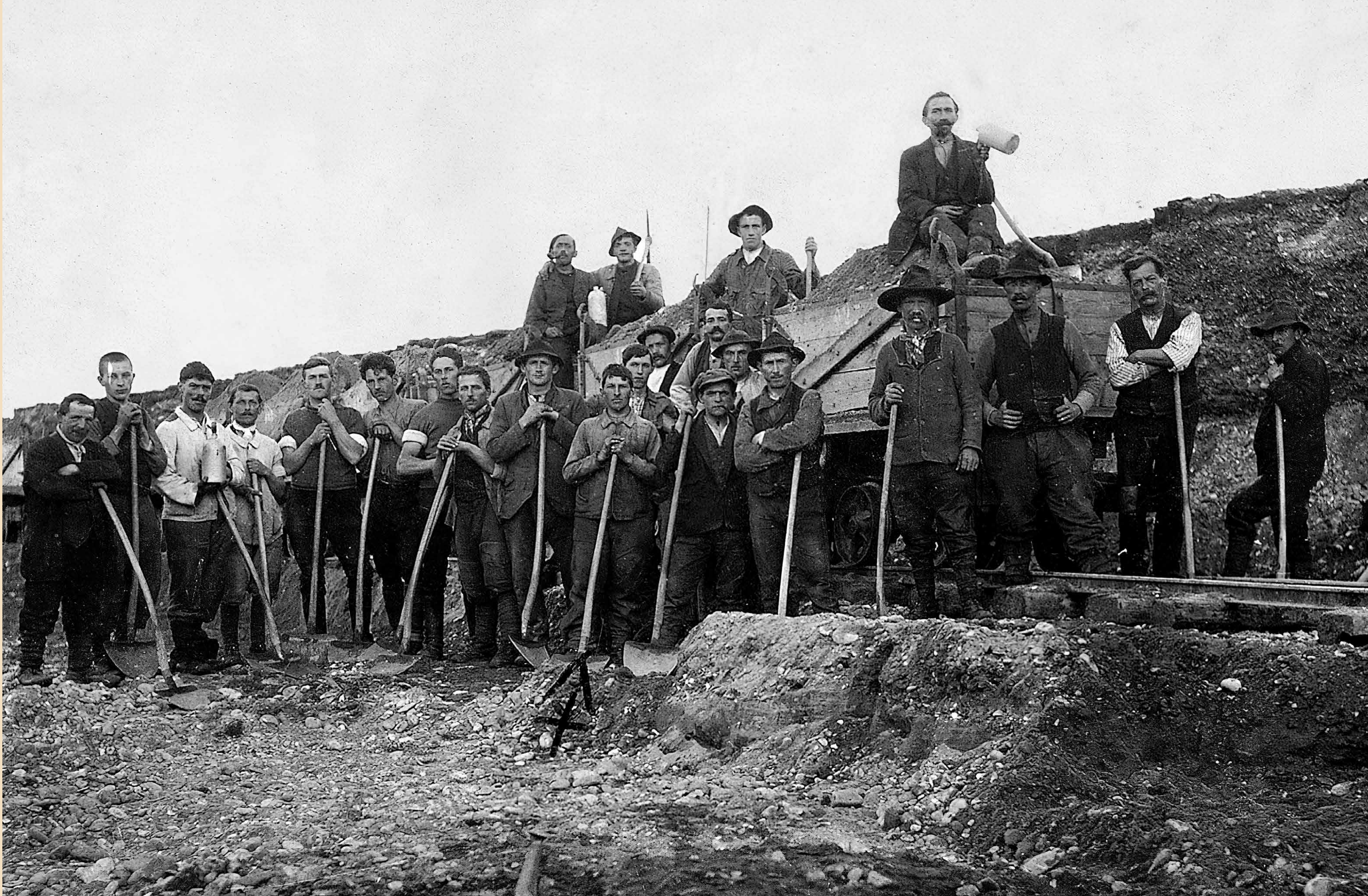
Arbeiter der Rheinregulierung beim Bau des Diepoldsauer Durchstichs, Quelle: Gemeinde Mäder
