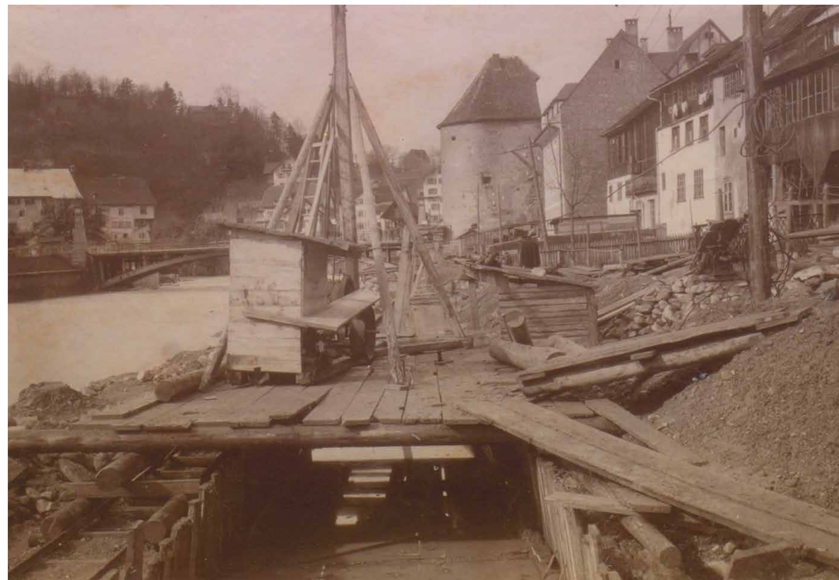
Bau der rechten Illufermauer, Höhe Wasserturm. Fotograf Alois Gnädinger, 1914.
