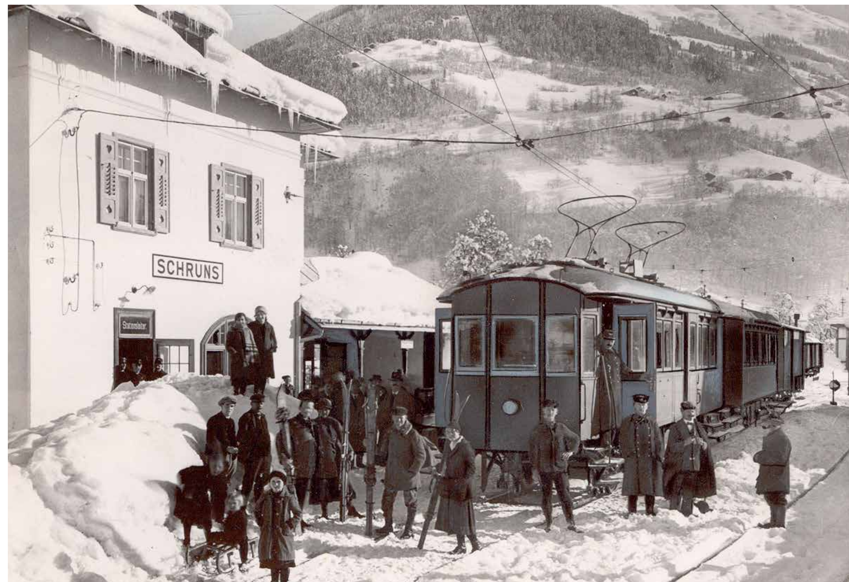
Zuggarnitur der Montafonerbahn im Bahnhof Schruns
