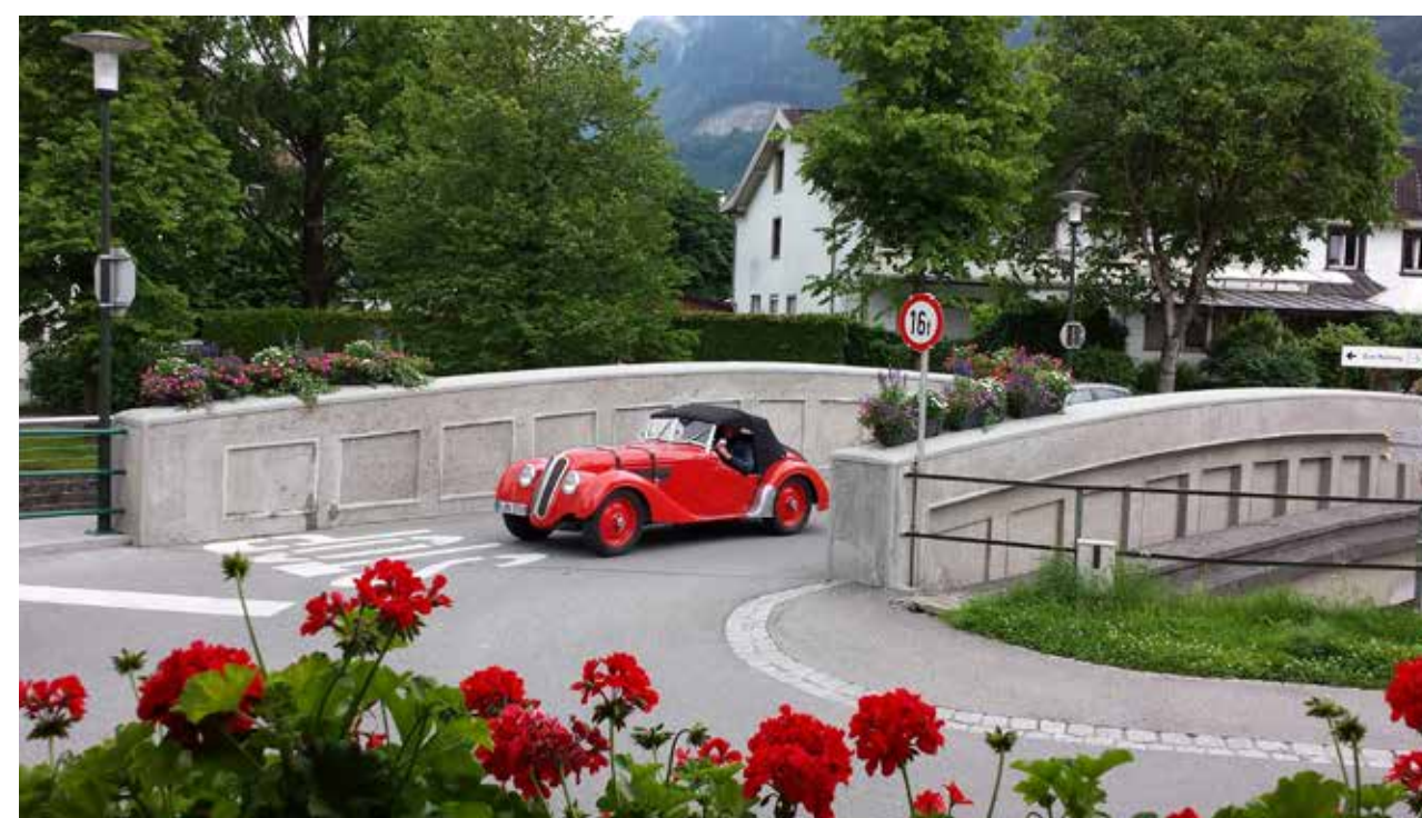
Die Mengbachbrücke 2013 GA Nenzing
