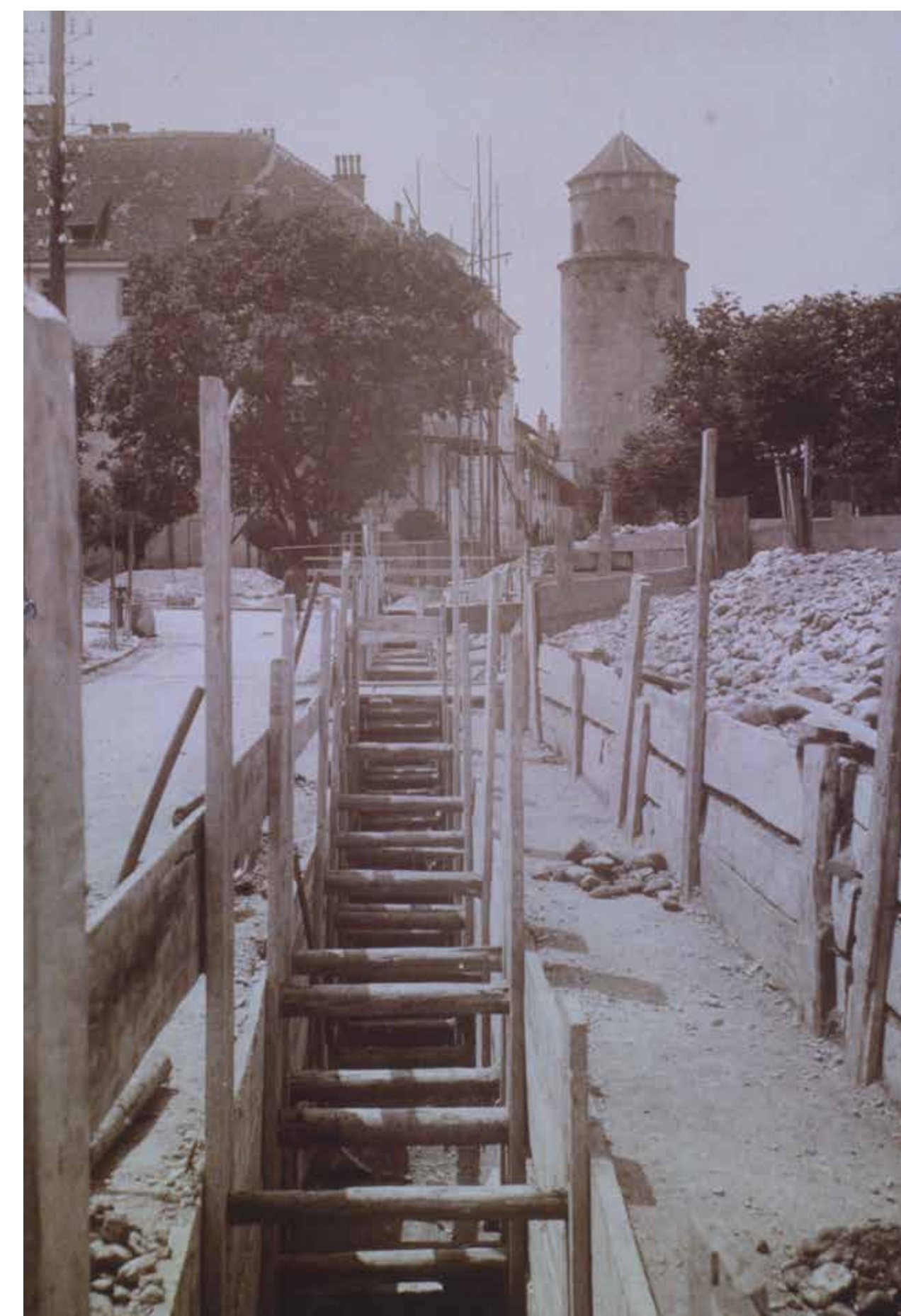
Die Kanalisation der Reichsstraße, im Hintergrund der Katzenturm.
